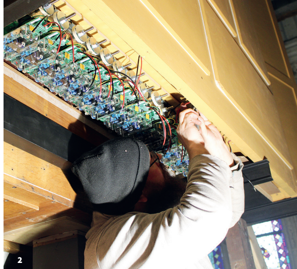
2 - Ces moteurs de registres sont bientôt fixés à leurs emplacements sous la boîte du Récit.
