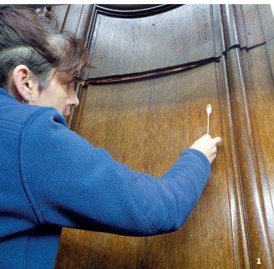
1 - L'épiderme du buffet est testé afin de déterminer l'option la plus judicieuse à prendre quant à la qualité et la tonalité du nouveau vernis à utiliser.
