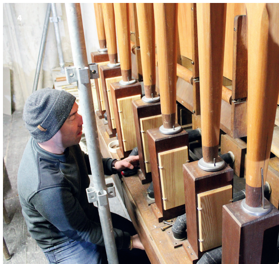
4 - Les plus grands tuyaux, et particulièrement les deux jeux de 32' postés contre la paroi de la Tour Saint-Michel, n'ont pu, en raison de leur encombrement, être emmenés dans l'atelier du facteur. Ils doivent donc être réharmonisés sur place.
